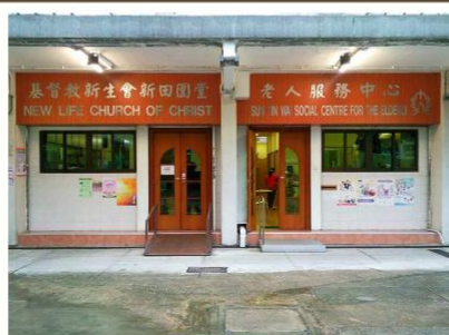
新田圍堂現貌
